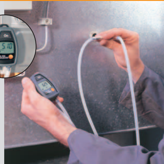
Medir caudal de aire con tubo de Pitot
