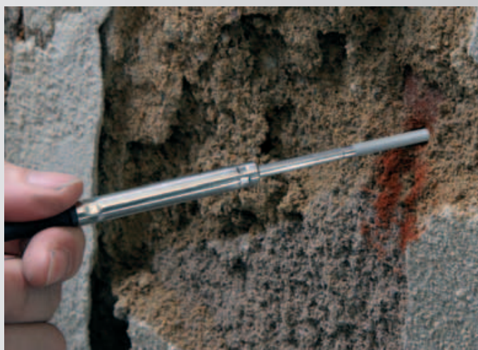
Introducir la sonda de humedad con filtro de Teflón de protección en un agujero taladrado
