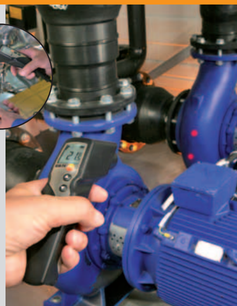
Comprobación de la temperatura de un compresor
