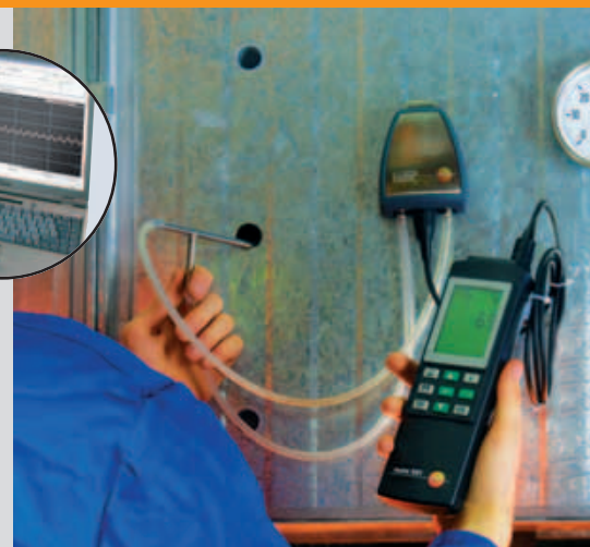
Medición con tubo Pitot con sonda de presión externa 100 Pa
