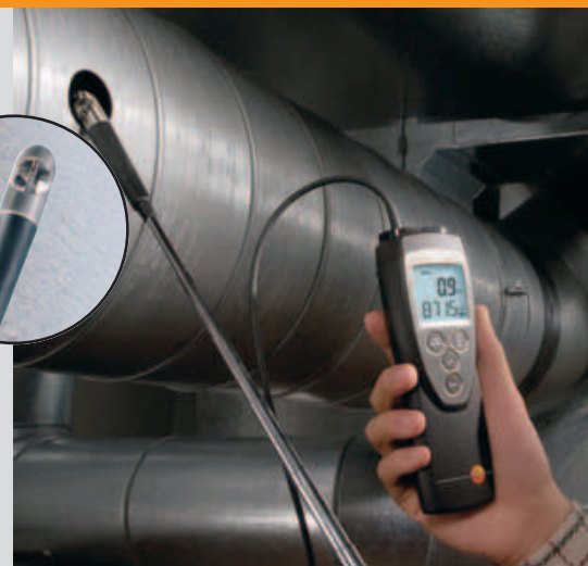
Control de la velocidad del aire en conductos de aire acondicionado
