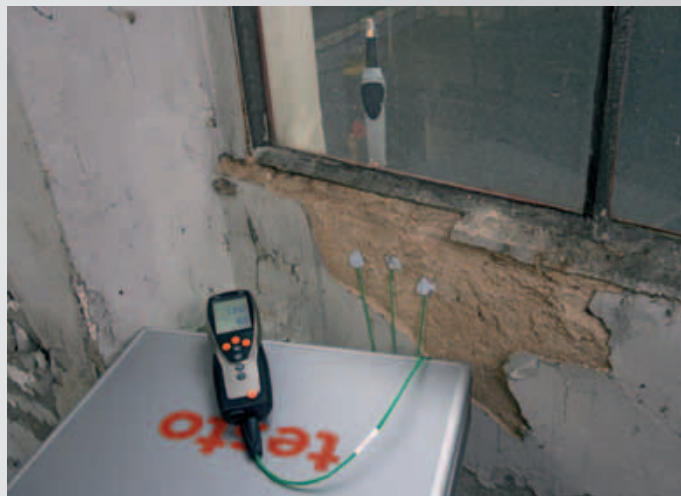
Medición del valor U en paredes estropeadas mediante la sonda de valor U y una sonda inalámbrica de humedad/temperatura (también se puede usar una sonda convencional con cable)
