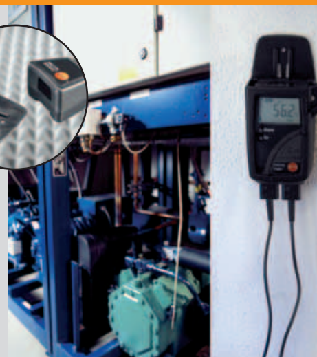
Medición de temperatura de ida y retorno en unidades de refrigeración
